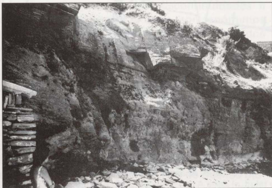
Figura 8.- Vista del talud de la Zona B de la cala, donde se observan los grandes bloques fracturados en el nivel calcarenítico y los voladizos a favor de los planos de estratificación.
